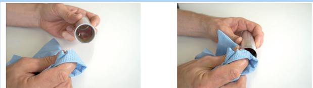
Abbildung 155: Gleitbuchsenrohr reinigen
